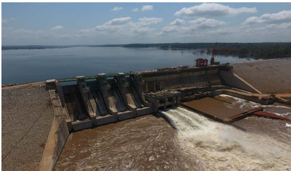
Barrage de Lom Pangar
